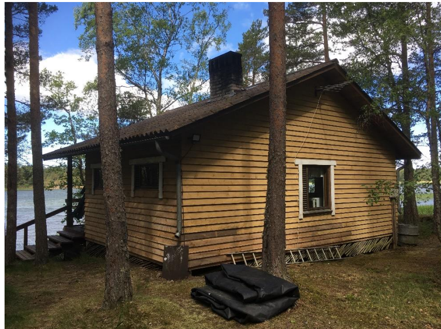
Lomarakennus kiinteistön 833-439-2-99 ranta-alueella Naurisluodossa
