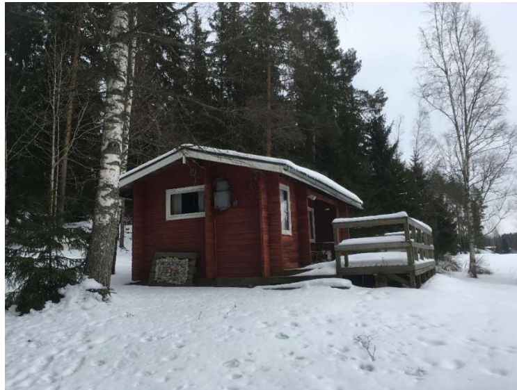
Saunamökki kiinteistön 271-452-4-63 alueella
