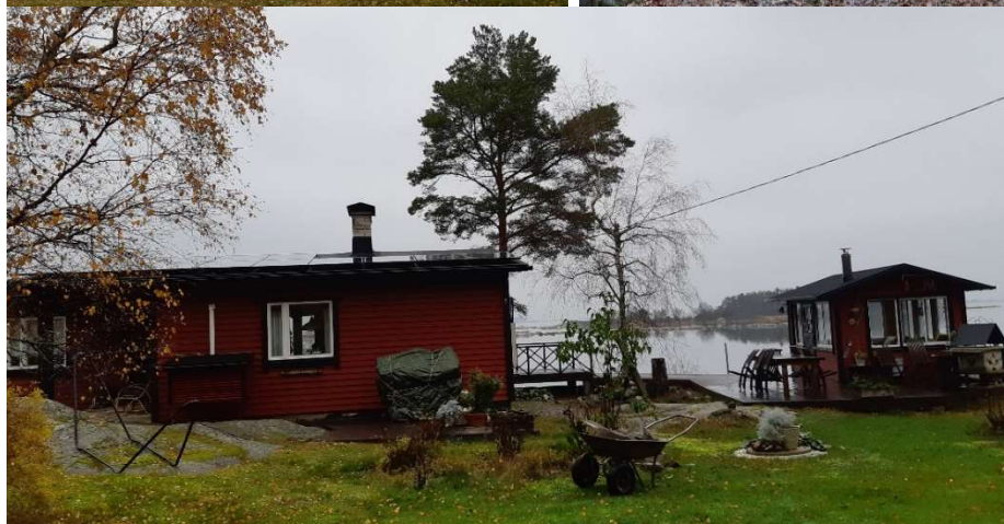
Kiinteistön 895-480-4-55 Lekkila rakennuksia
