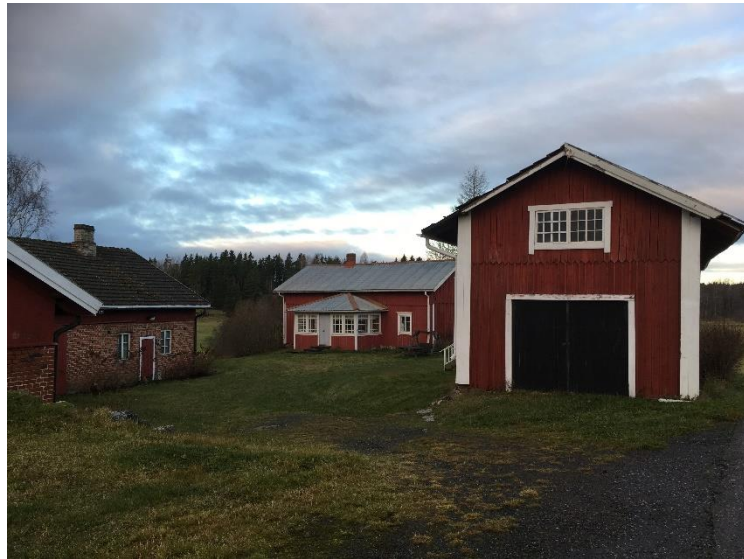
Kalliolan tilakeskuksen pihapiiriä (päärakennus keskellä)
