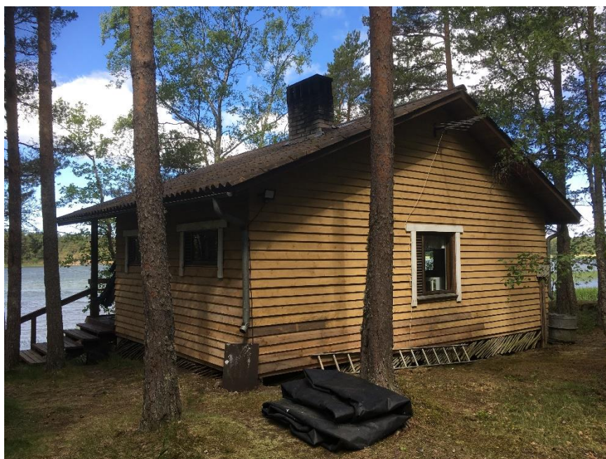
Lomarakennus kiinteistön 833-439-2-99 ranta-alueella Naurisluodossa
