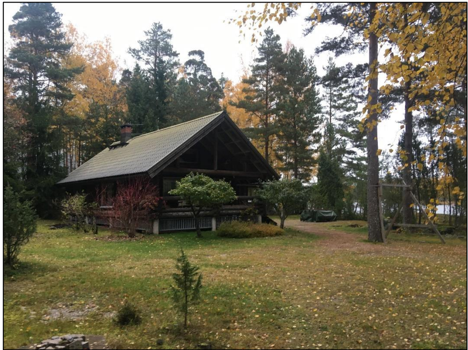
Lomarakennuspaikan vapaa-ajan asuinrakennus ja piha-alue.
