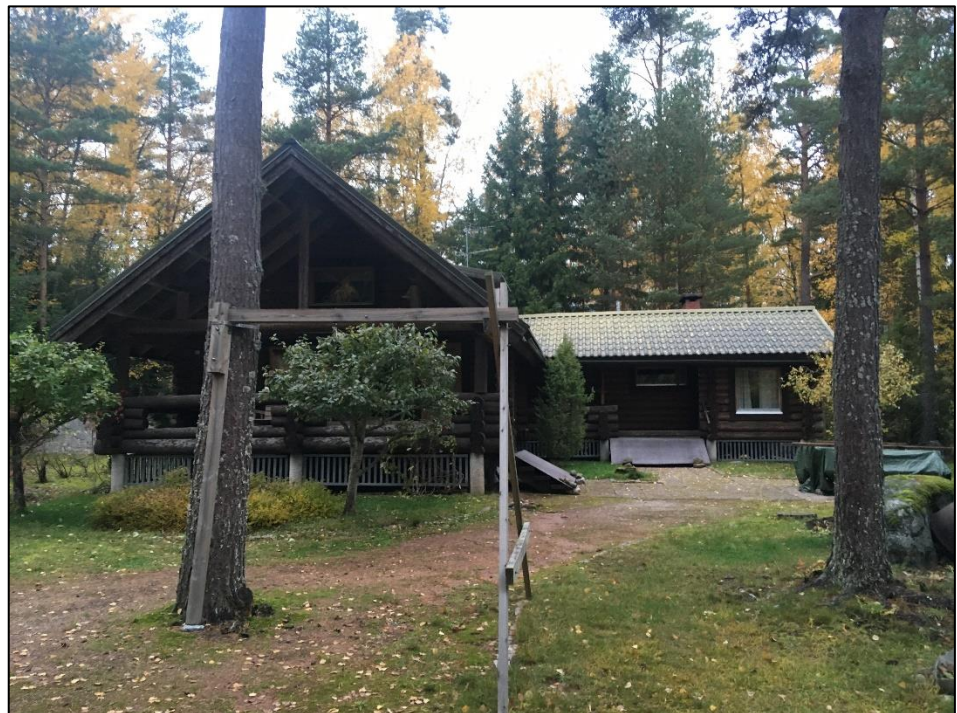
Lomarakennuspaikan vapaa-ajan asuinrakennus.
