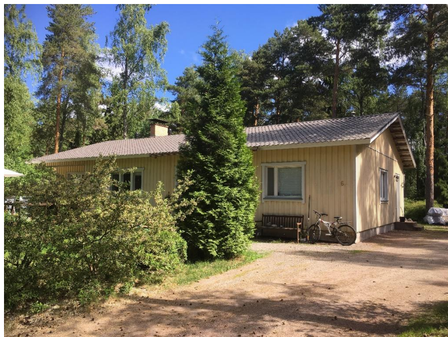
Asuinrakennus kiinteistön 833-439-2-99 alueella Naurisluodossa
