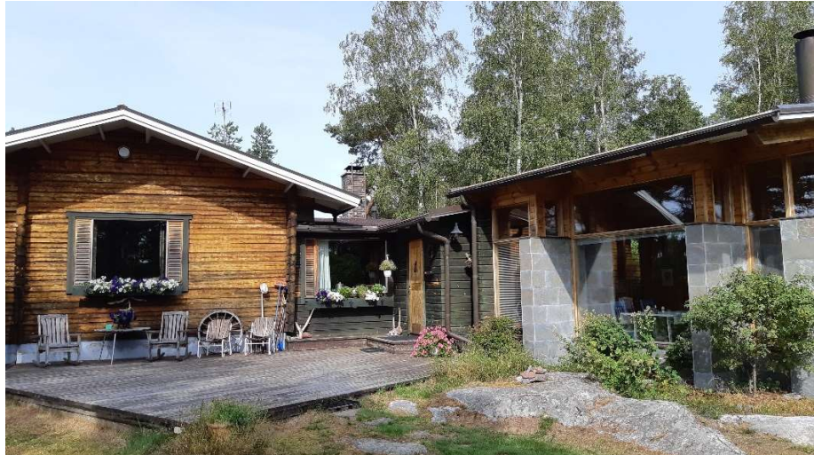
Ranta-asemakaavassa AO-rakennuspaikaksi osoitettavan kiinteistön Huuvari 895-533-1-155 päärakennus. Kuva: Antti Siirava
