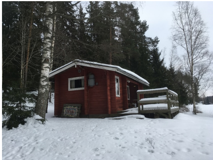
Saunamökki kiinteistön 271-452-4-63 alueella
