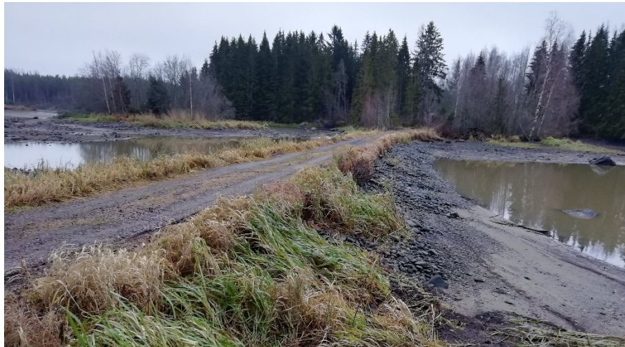
Sahanluodon saareen johtava tie 9.1.2020 / Kuva Mikko Eskola (lisätty 24.1.2020)
