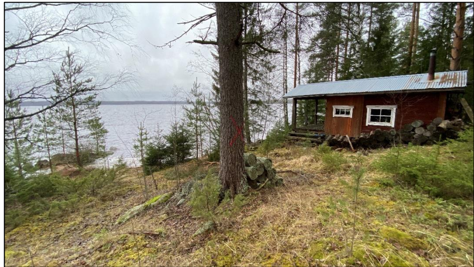
Saunarakennus suunnittelualueella. Kuva kaakosta.
