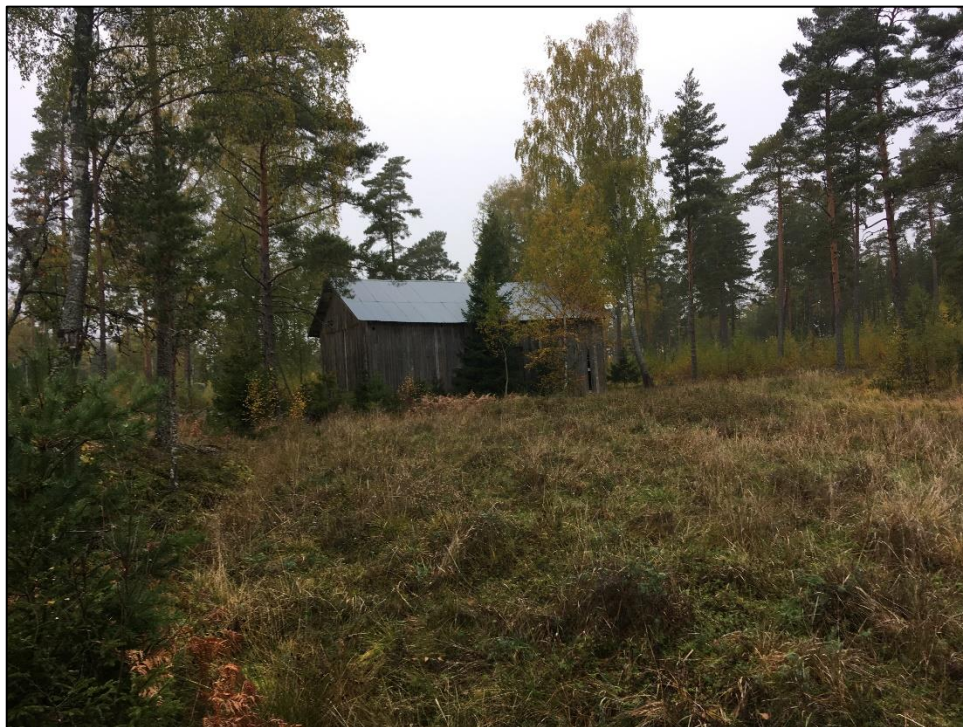
Maatilan rakennuksiin kuuluva lato hieman kauempana pihapiiristä.
