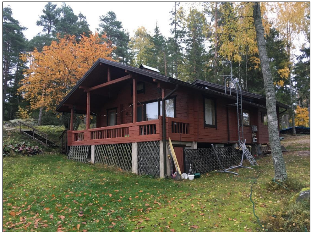
Vapaa-ajan asuinrakennus kiinteistöllä 895-472-3-11 Pesäkolo.
