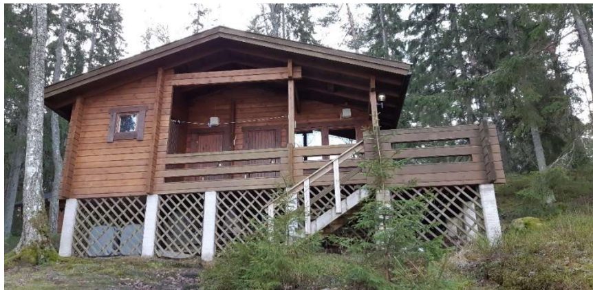
Saunarakennus kaavamuutoksen RA-alueella. Kuva: Antti Siirava
