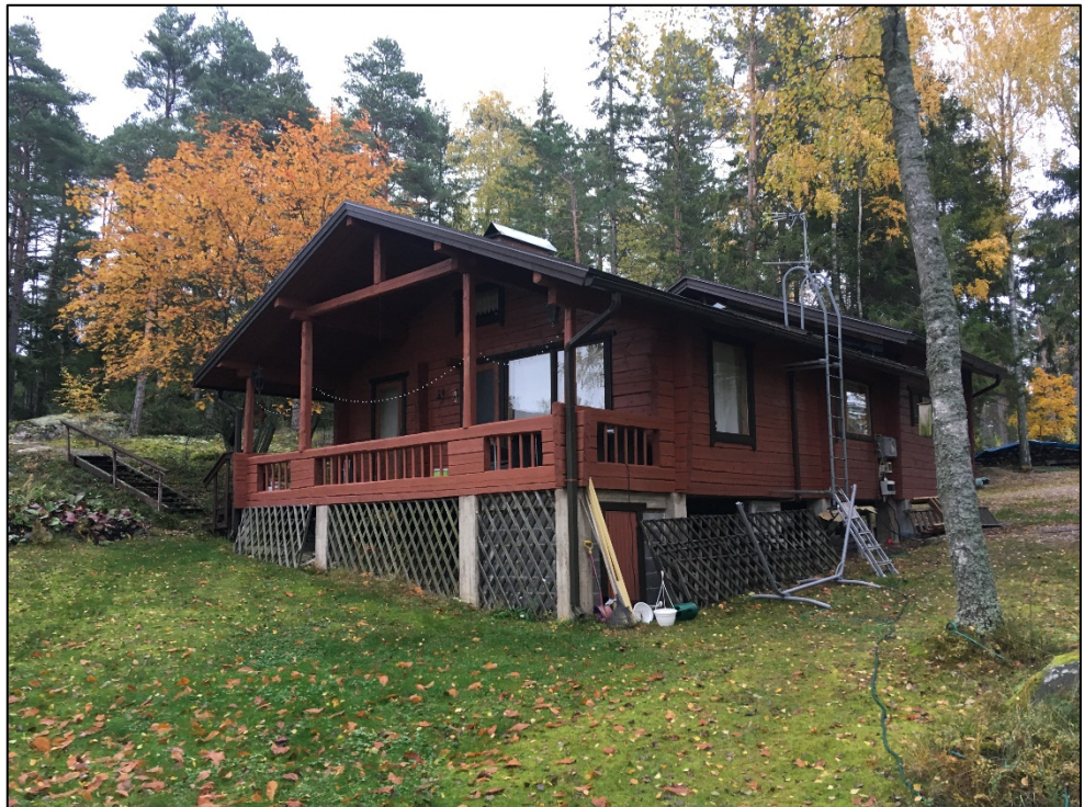
Vapaa-ajan asuinrakennus kiinteistöllä 895-472-3-11 Pesäkolo.
