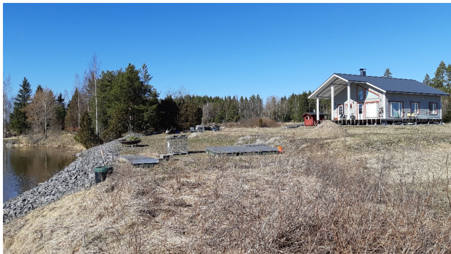
Suunnittelualueella sijaitseva rakennuspaikka
