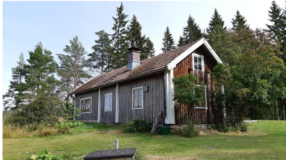
Kiinteistön Huuvuri I 895-533-1-125 päärakennus, joka osoitetaan ranta-asemakaavassa suojeltavaksi rakennukseksi.
