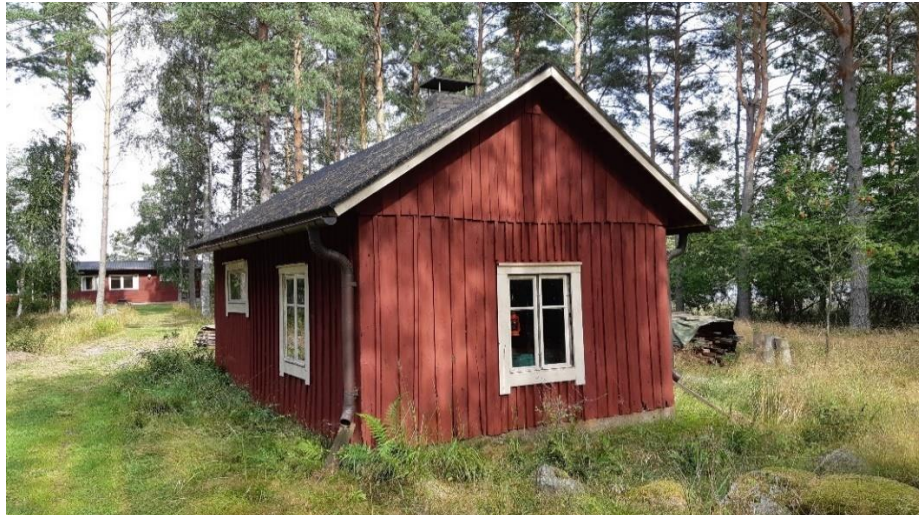
Kiinteistön Heilala 895-533-1-89 korttelin 4 rakennuspaikalla 4 sijaitseva ranta-asetmakaavassa suojeltava rakennus.
