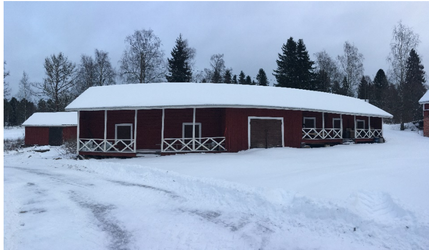
Rakennus Kaupparamäen pihapiirissä. Kuvat: Pasi Lappalainen
