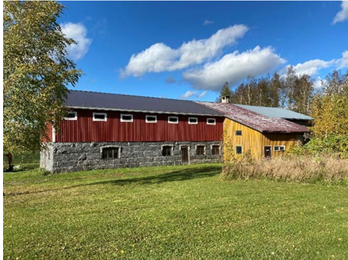
Osin kiinteistön 413-408-6-49 KALLIO alueella sijaitseva vanha navettarakennus.
