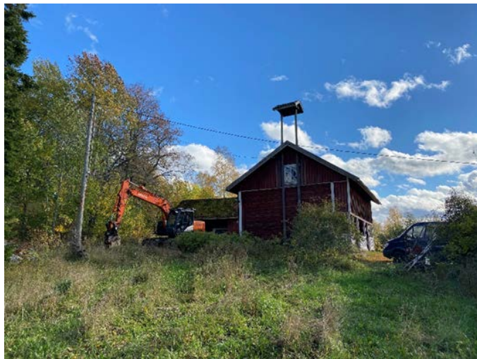
Maatilan talousrakennus kiinteistöllä 413-408-6-49 KALLIO.
