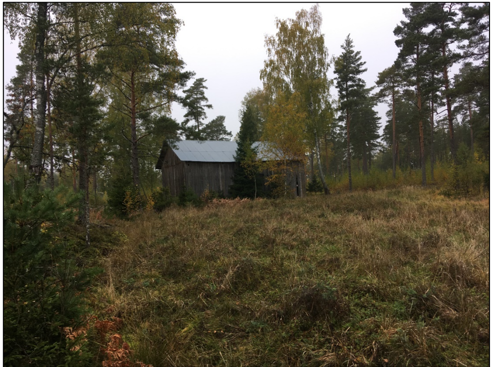
Maatilan rakennuksiin kuuluva lato hieman kauempana pihapiiristä.
