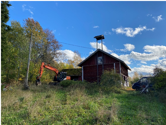
Maatilan talousrakennus kiinteistön 413-408-6-49 alueella.
