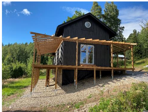
Asuinrakennus kiinteistöllä 444-455-1-24 PÄIVÄRINNE.
