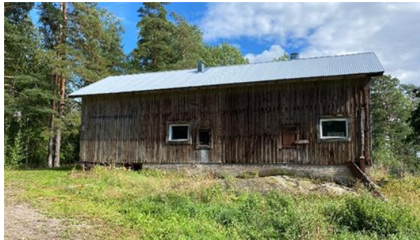
Navettarakennus kiinteistöllä 444-455-1-24 PÄIVÄRINNE.
