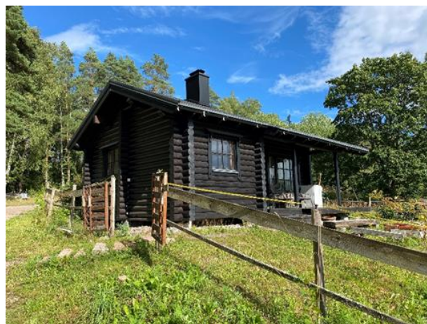
Saunarakennus kiinteistöllä 444-455-1-24 PÄIVÄRINNE.
