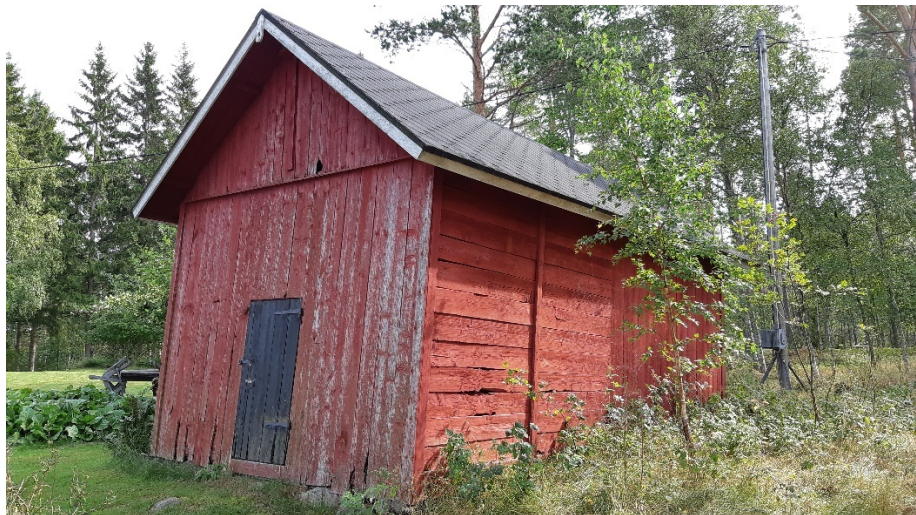
Kiinteistön Huuvuri I 895-533-1-125 talousrakennus, joka osoitetaan ranta-asemakaavassa suojeltavaksi rakennukseksi.
