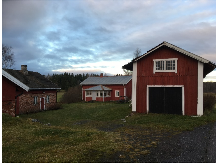
Kalliolan tilakeskuksen pihapiiriä (päärakennus keskellä)
