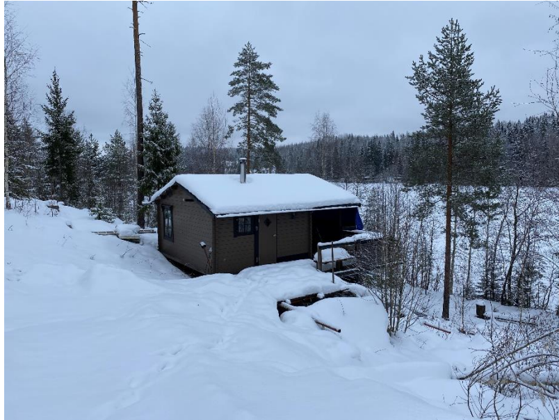
Saunarakennus kiinteistöllä 111-413-3-5 Komeanrinne.
