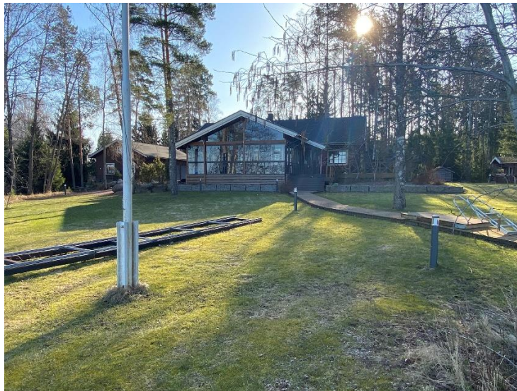
Vapaa-ajan asuinrakennus. Autokatos kuvassa vasemmalla.
