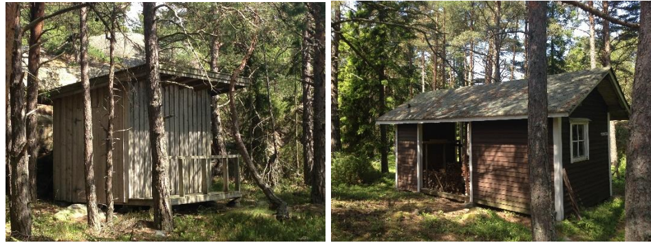
Talousrakennuksia kiinteistöllä 304-403-34-0 ETELÄPUISTO.
