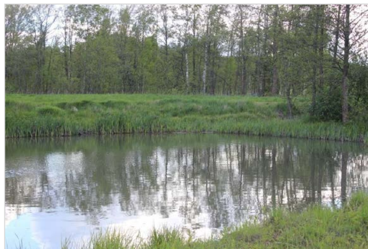
Kaivettu uudempi saostusallas, kemikaalikäsittely (kuva: Marika Vahekoski)
