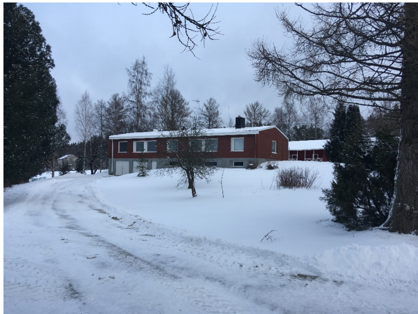
Suunnittelualan pihapiiriin uudempi rakennus. Kuva: Pasi Lappalainen
