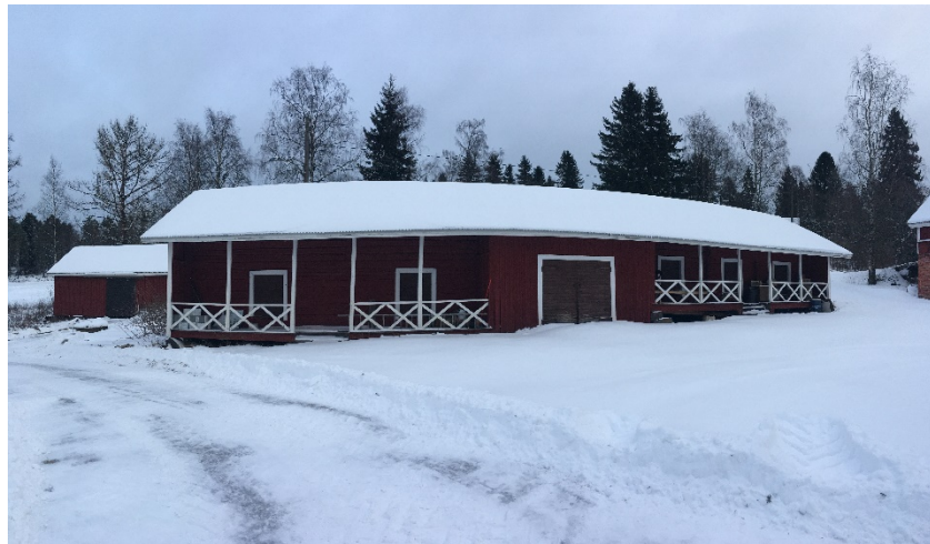
Rakennus Kaupparamäen pihapiirissä. Kuvat: Pasi Lappalainen
