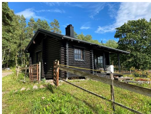
Saunarakennus kiinteistöllä 444-455-1-24 PÄIVÄRINNE.
