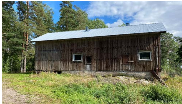
Navettarakennus kiinteistöllä 444-455-1-24 PÄIVÄRINNE.
