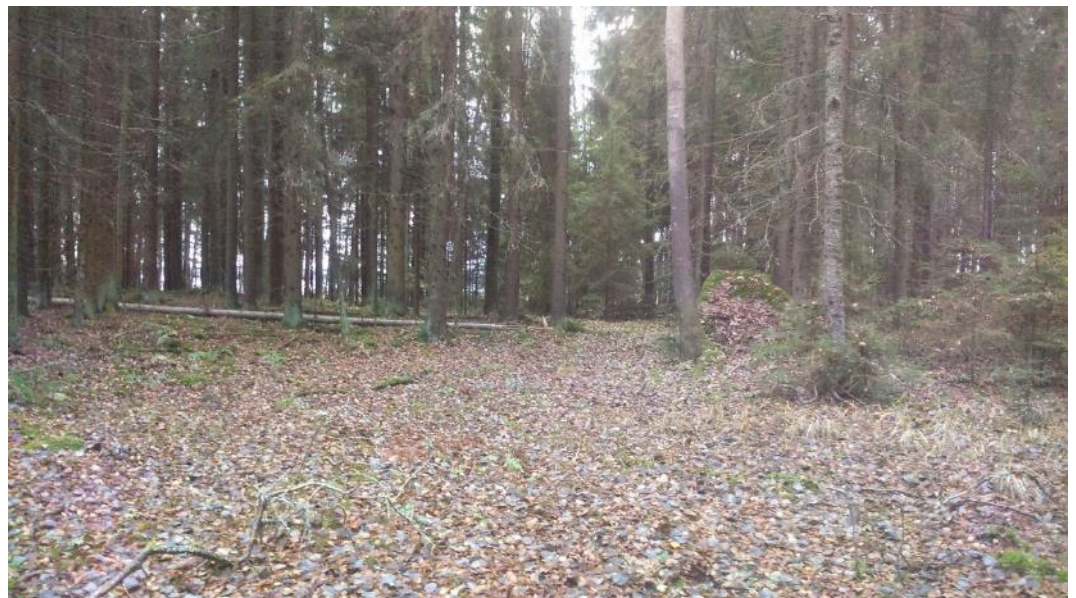
Kuva 6. Raivattu ja tasattu maanpinta Hietasaaren eteläosissa.
