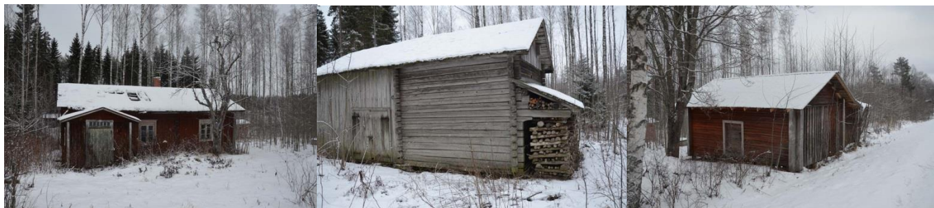
Kuvat: Koiviston rakennuksia, asuinrakennus, riihi ja aitta
