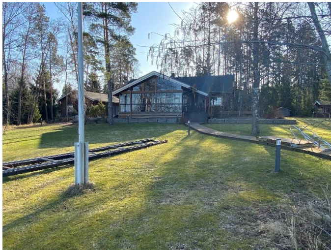
Vapaa-ajan asuinrakennus. Autokatos kuvassa vasemmalla.
