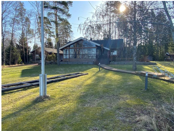
Vapaa-ajan asuinrakennus. Autokatos kuvassa vasemmalla.
