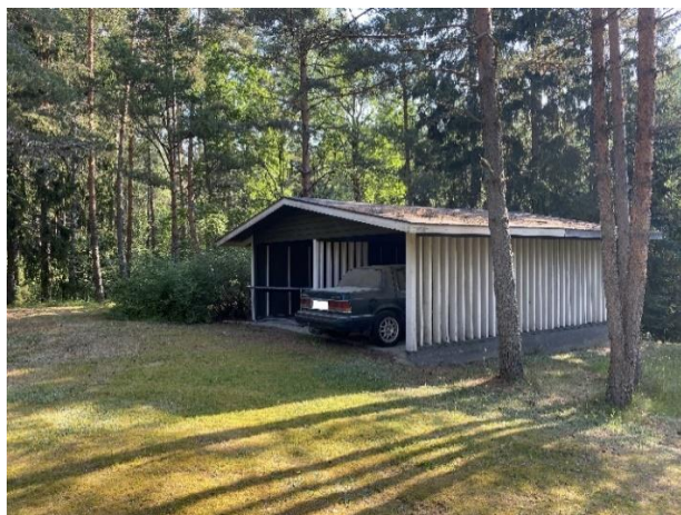
Carport i östra delen av planeringsområdet.
