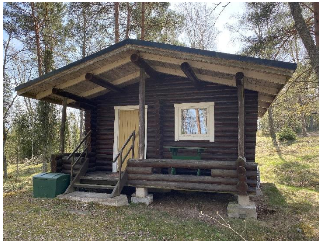
Saunarakennus kiinteistön 322-412-1-19 alueella.
