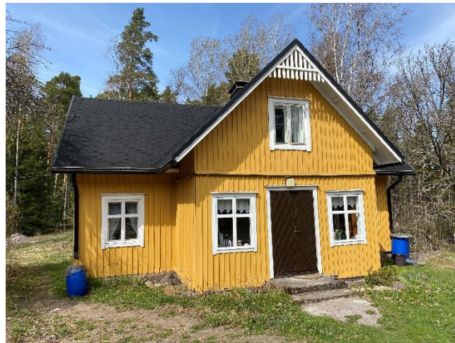
Vapaa-ajan asuinrakennus kiinteistön 322-412-1-19 alueella. Vanhan talouskeskuksen rakennus.
