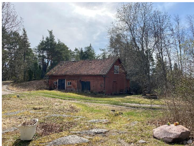
Ekonomibyggnad vid det gamla driftcentrumet på fastigheten 322-412-1-19.
