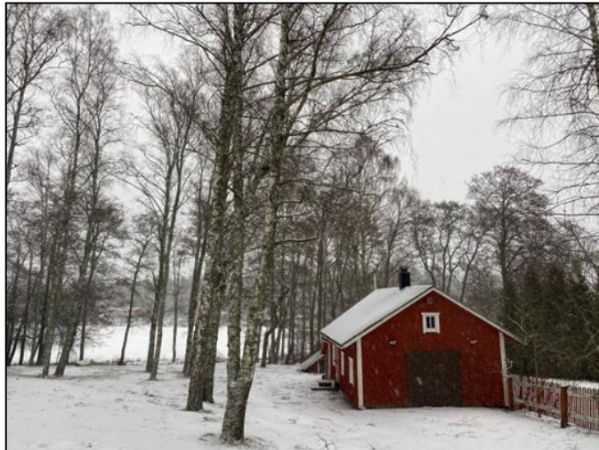
Majoitus/talousrakennus, joka on alun perin navetasta korjattu autotalliksi/grilli-keittiöksi.
