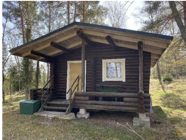
Saunarakennus kiinteistön 322-412-1-19 alueella.
