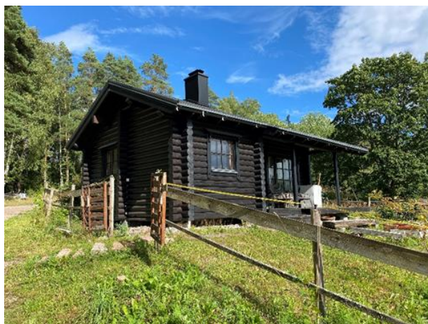
Saunarakennus kiinteistöllä 444-455-1-24 PÄIVÄRINNE.
