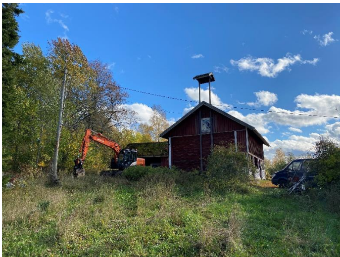
Maatilan talousrakennus kiinteistön 413-408-6-49 alueella.
