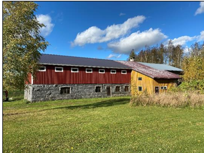
Osin kiinteistön 413-408-6-49 KALLIO alueella sijaitseva vanha navettarakennus.
