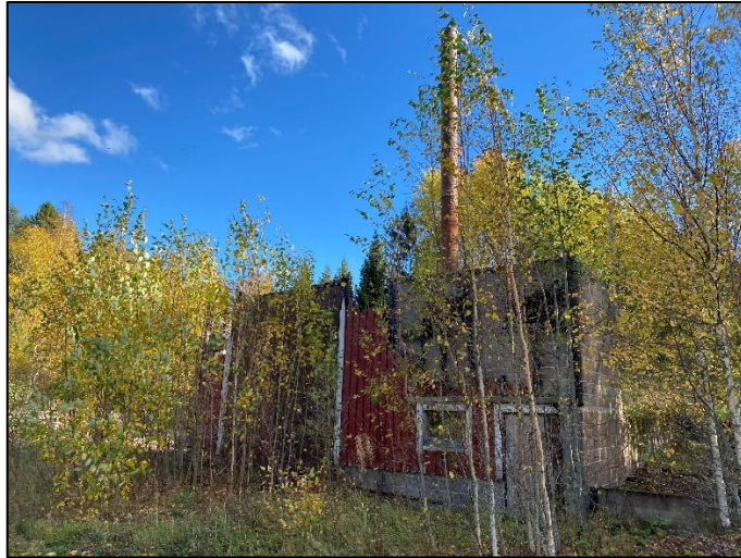
Palanut kuivaamorakennus suunnittelualueen kiinteistöllä 413-408-6-49 KALLIO.
