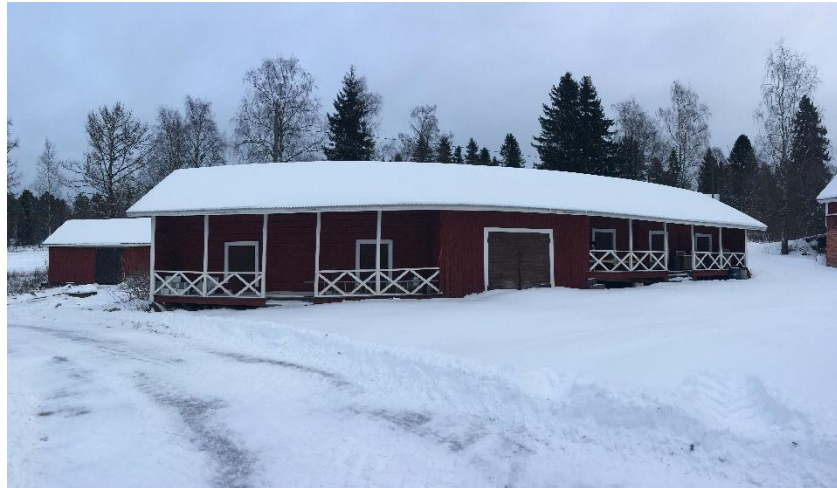
Rakennus Kaupparamäen pihapiirissä. Kuvat: Pasi Lappalainen
