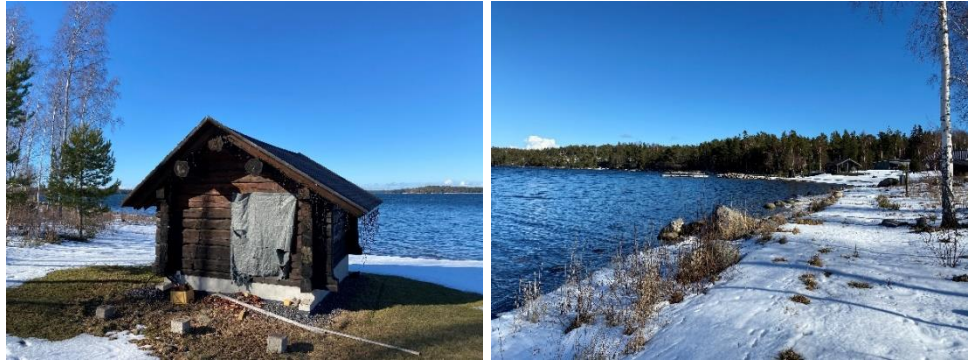
Suunnittelualueen rakenteilla oleva savusauna ja rakennuksia suunnittelualueen lähiympäristössä.
