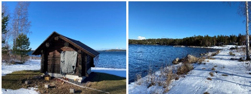
Rökbastun som håller på att byggas och byggnader i planeringsområdets näromgivning.
