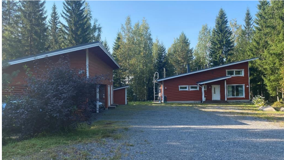
Olemassa olevaa rakentamista Väliveden itärannalla kiinteistöllä 989-402-2-77.
