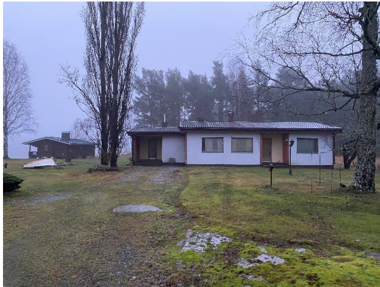
Kiinteistöllä 833-435-1-38 oleva erillispientalo ja saunarakennus.
