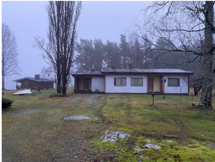
Kiinteistöllä 833-435-1-38 oleva erillispientalo ja saunarakennus.
