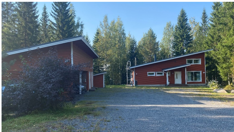
Olemassa olevaa rakentamista Väliveden itärannalla kiinteistöllä 989-402-2-77.
