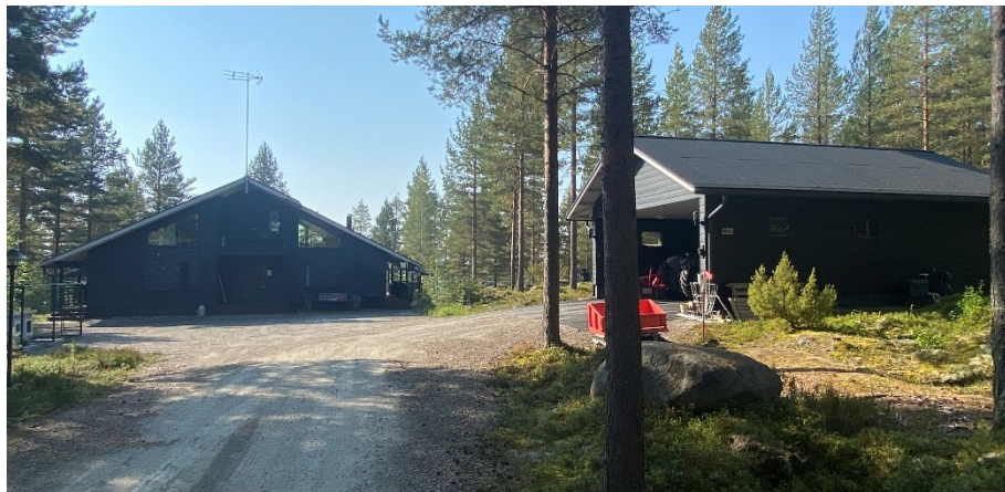
Olemassa olevaa rakentamista Väliveden itärannalla kiinteistöllä 989-402-2-73.
