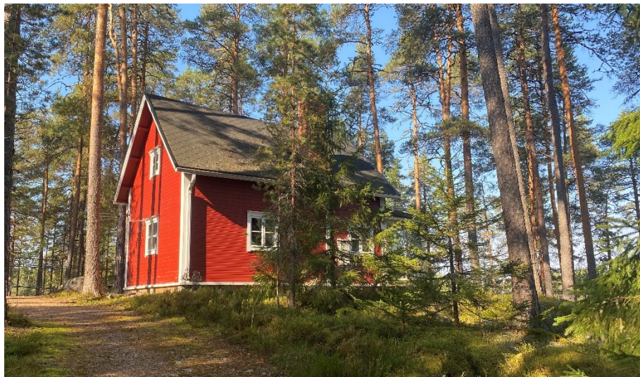
Voimassa olevassa rantayleiskaavassa sr-merkinnällä osoitettu vanha huvilarakennus.
