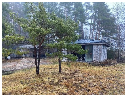
Kiinteistöllä 833-429-2-90 Laurinkari III olevat piha- ja saunarakennus.
